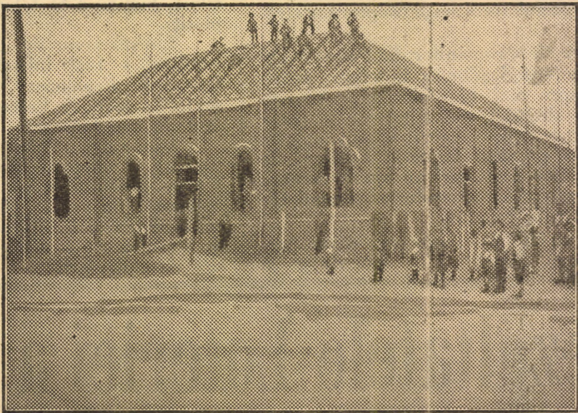
Casa Națională din Petrești, în construcție
