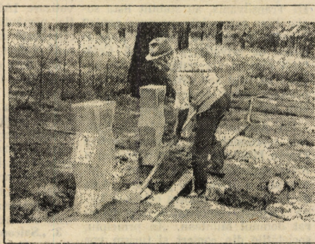
Ioan Velțan cu ocazia primelor lucrări de renovare ale cimitirului eroilor din Veștem.
