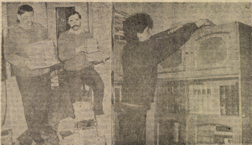
Aspecte din timpul reamenajării Bibliotecii Clubului Sindicatului Indes S.A. (fostă Independența) la sediul clubului din str. Avram Iancu nr. 10. Există speranțe că în curînd, aici, va fi un focar de cultură de care avem atît de multă nevoie.
