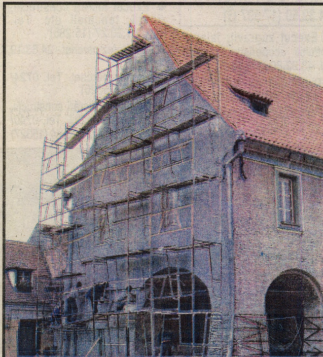
La Casa Artelor din Piața Mică (Sibiu), aflată pe "masa de operație" a constructorilor și restauratorilor, au început lucrările de finisări exterioare.
