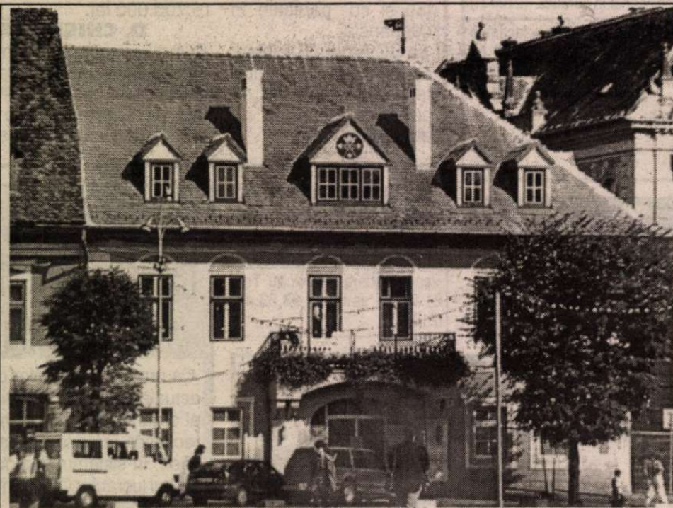
Spre exterior, lucrările de mansardare a sediului Forumului Democrat German din Sibiu s-au încheiat. Încă o clădire din Piața Mare (pe lângă Muzeul Brukenthal) care își "ia fața"!
