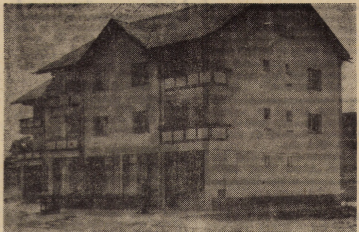
Una din noile construcții de locuințe cu parter comercial, amplasată lângă Piața 8 Mai din Sibiu-Turnișor
