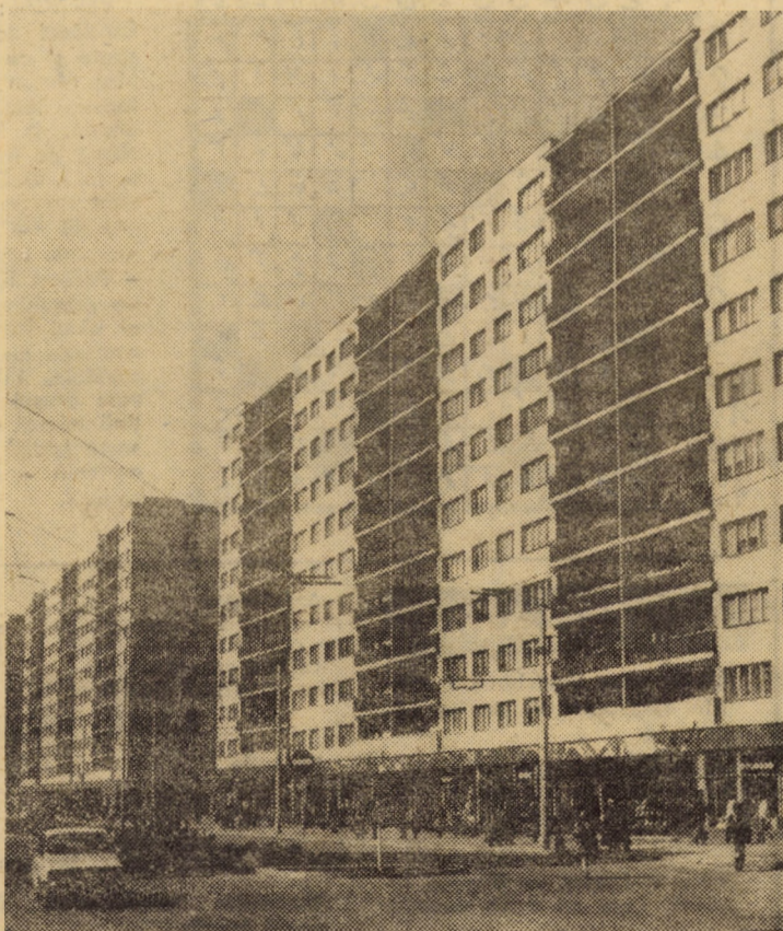
An de an peisajul arhitectonic din municipiul Sibiu s-a îmbogățit cu noi și impunătoare construcții de locuințe dintre care vă prezentăm pe cele din b-dul Mihai Viteazul — cartierul Hipodrom Foto: Fred NUSS
