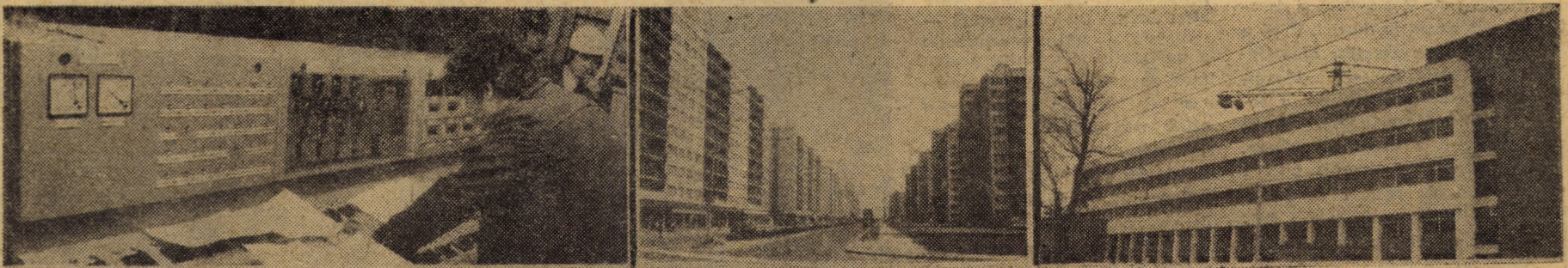
Amplul program de investiții de care a beneficiat județul nostru s-a materializat în acești ultimi ani în construirea și dezvoltarea a noi capacități de producție și a mii de apartamente confortabile. Imaginile alăturate sînt sugestive în acest sens. Foto: Fr. NUSS
