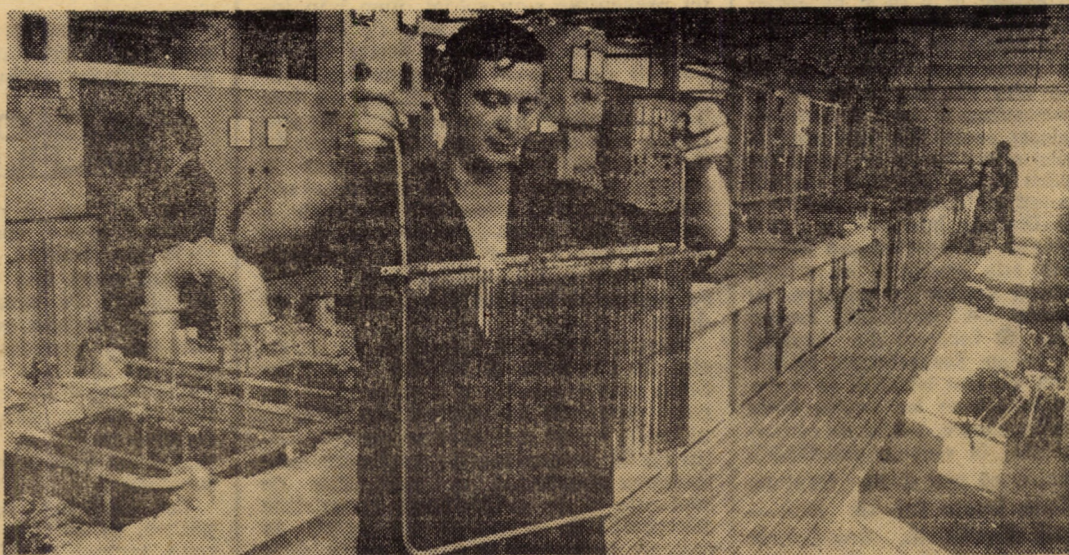
Recent, la secția metal II a întreprinderii „Flamura roșie” din Sibiu, a fost dată în funcțiune o linie modernă de zincare, realizată prin autoutilare, în cadrul noii hale de acoperiri galvanice, fapt care a dus la dublarea capacității. Foto: FRED NUSS
