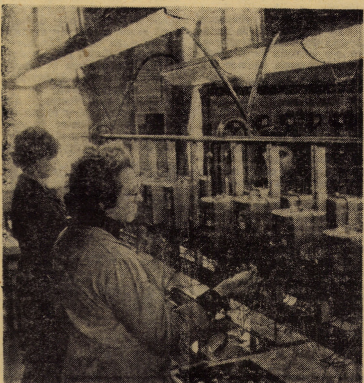
În sala de etalonare și verificare aparate de măsură de la I.R.E. Sibiu, contoarele electrice, înainte de-a ajunge la consumatori, sînt supuse unor riguroase verificări metrologice. Foto: FR. NUSS
