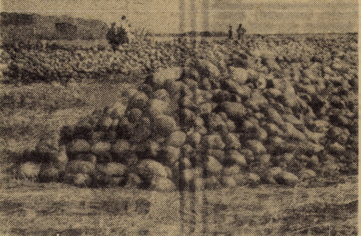
Roadele muncii așteaptă transportul la timp, pentru a nu se deprecia din cauza intemperiilor
