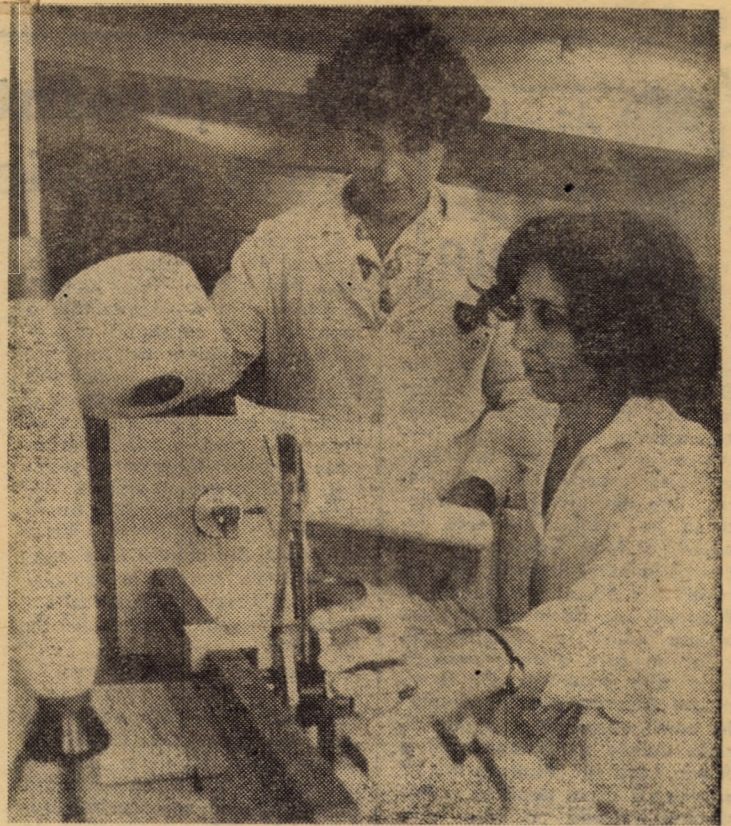
Determinarea numărului de răsucituri al firelor — una din probele efectuate zilnic în Laboratorul central fizico-chimic al întreprinderii „Tirnavă” Mediaș. În fața aparatelor: laborantele Silvia Szöke și Viorica Hudea
