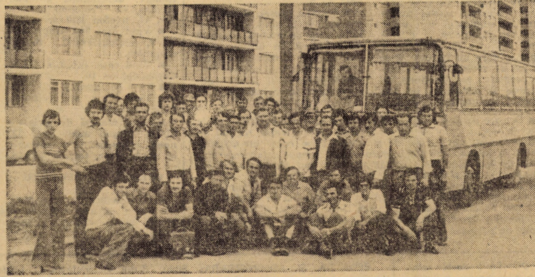
Un nou lot de 80 de constructori ai I.C.M.J. Sibiu gata de start spre șantierile construcției de locuințe din Zimnicea. Succes tuturor!
