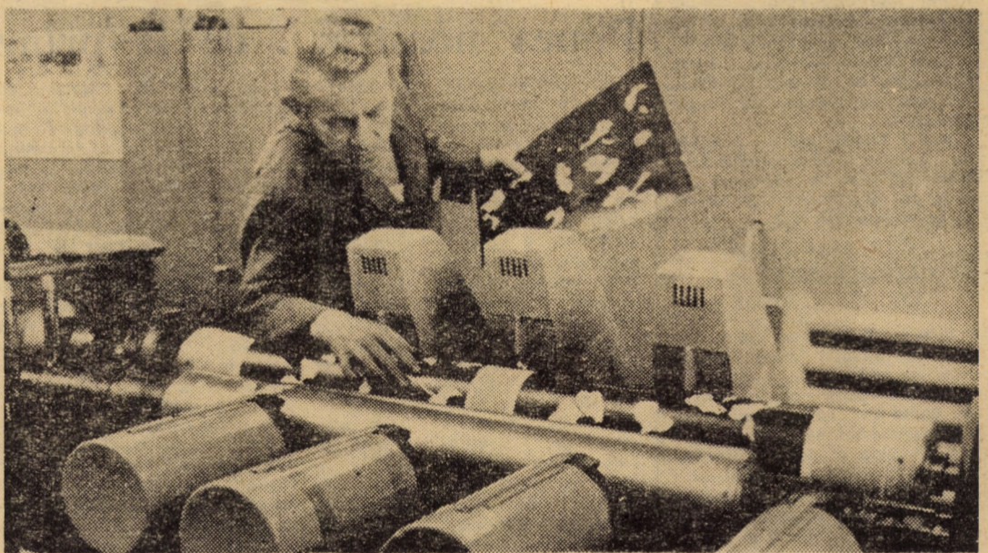
Transferul variatelor modele de pe desenele creatorilor pe țesăturile din pinză, produse de întreprinderea „Tirnavă” Mediaș, se realizează în secția fotografură cu ajutorul unei mașini electronice automate de gravat pe cilindri — utilaj de înaltă tehnicitate deservit de Ernest Jozsa Foto: FR. NUSS
