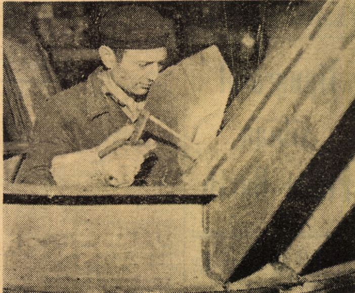
Cazangeria întreprinderii „Independența” Sibiu. Deși sudura automată ciștigă pe zi ce trece mai mult teren, unele construcții metalice necesită lucrări de sudură manuală, executate de sudori cu înaltă calificare
