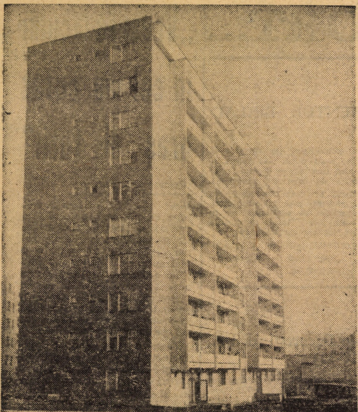
Una din cele mai înalte construcții din municipiul Mediaș: blocul turn din cartierul de locuințe Gura Cimpului.
