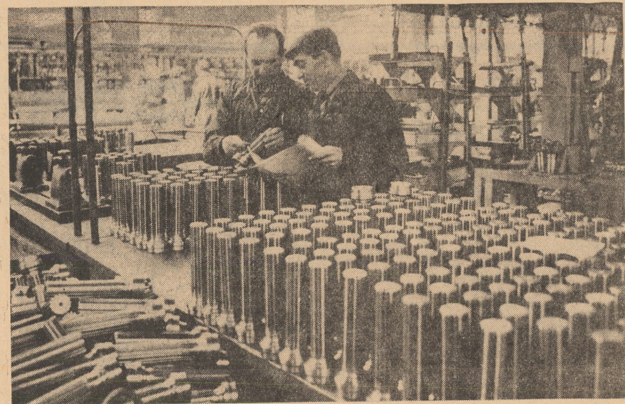
Compartimentul C.T.C. la linia de axe canelate pentru cardane de la I.P.A. Sibiu
