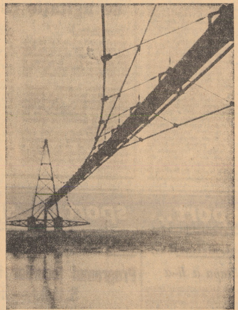
Traversare aeriană a unui curs de apă cu o conductă magistrală
