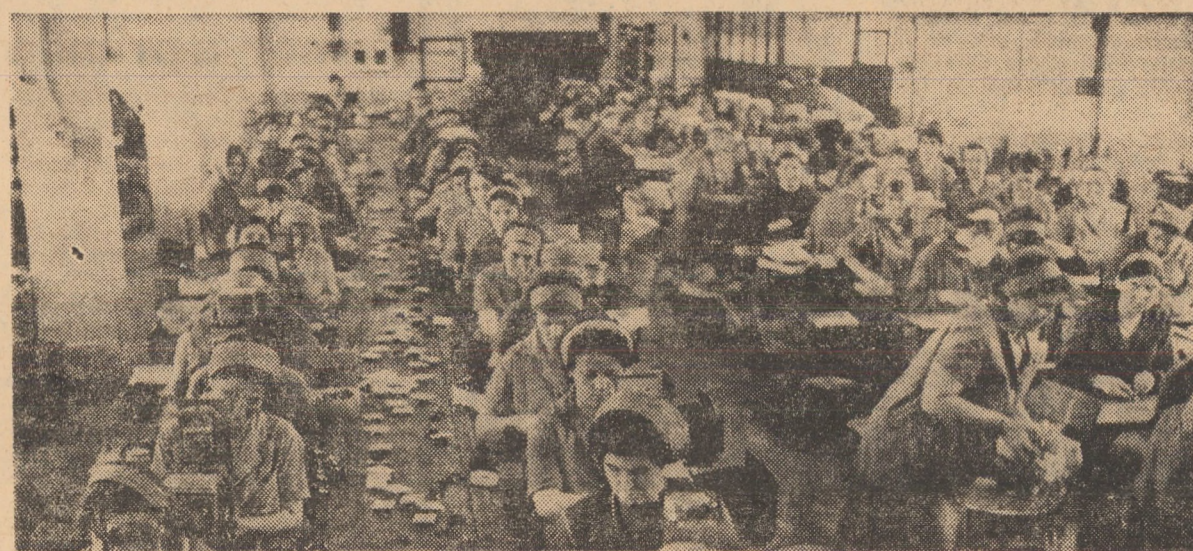
Aspect din secția de montaj pentru aparatul electric
