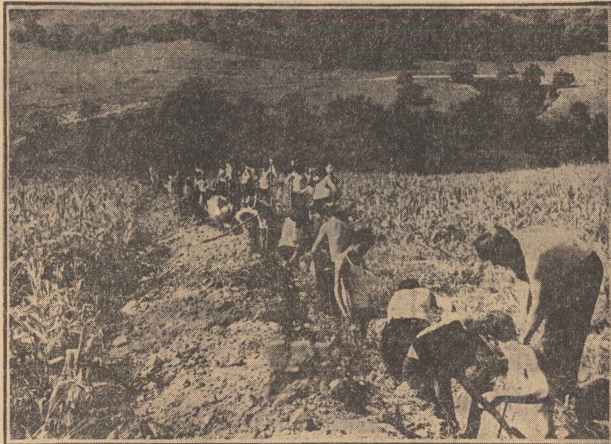
Muncă patriotică efectuată de cetățenii din satul Ruși, comuna Sîlmiac. Se lucrează la șanțul pentru conducta de alimentare (200 metri lungime) cu apă termală a viitorului bazin, ce va fi construit în apropiere de sat, avînd dimensiunile 20x25 metri
