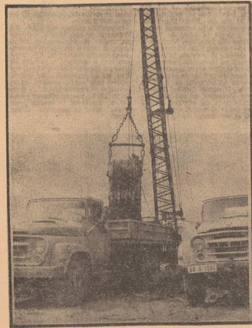
Santierul de construcție uzina „Balanta II”. Pentru a realiza o platformă pentru noile hale de producție, aici vor fi excavate cca 20 000 mc pămînt
