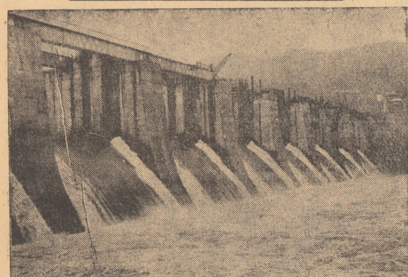
R.S.F. IUGOSLAVIA. La Porțile de Fier, România în colaborare cu Iugoslavia, construiește una din cele mai mari hidrocentrale din lume. În foto: gigantul baraj de pe malul iugoslav al Dunării cu o înălțime de 65 m
