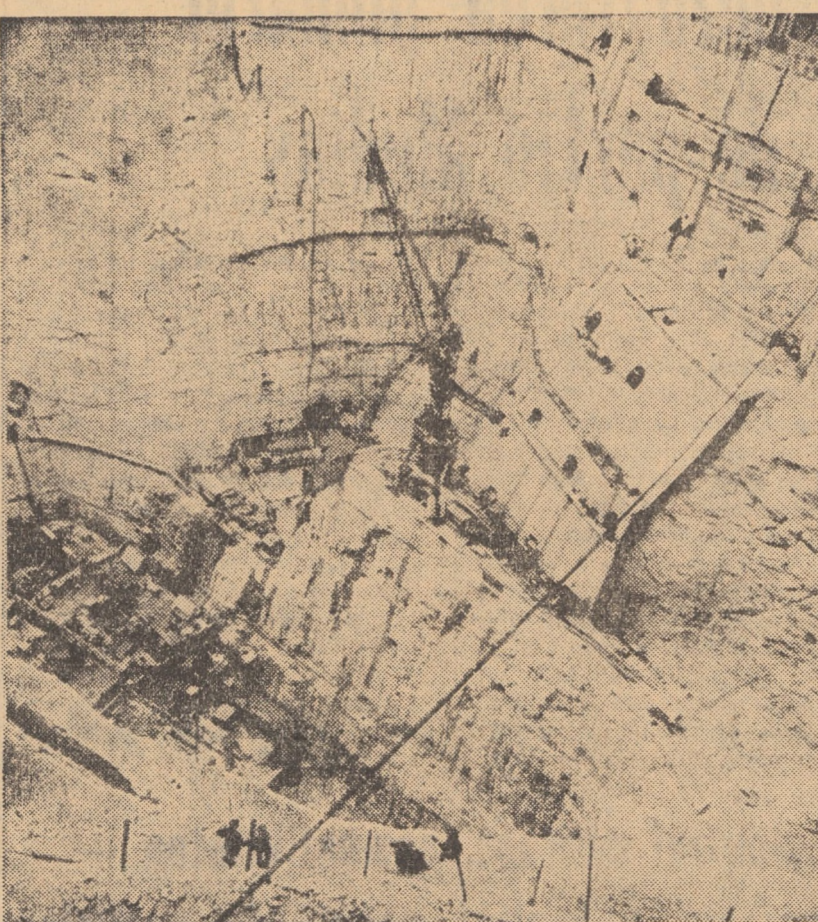
U.R.S.S. Pe riul Cirkei din Daghestan, în Kankazul de nord se construiește cea mai mare hidrocentrală electrică din această republică bogată în resurse de apă. Capacitatea ei va fi de miliarde de kW/h. În foto: fundațiile noului obiectiv.
