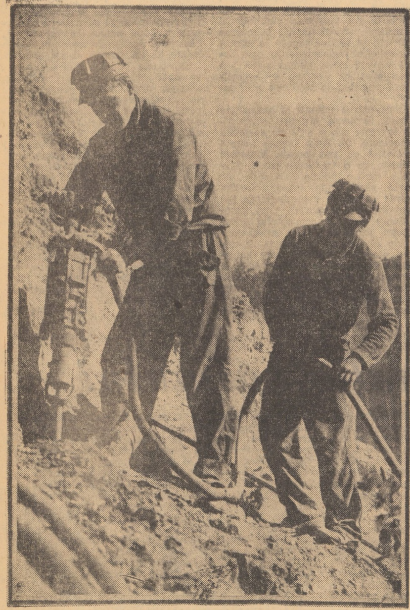
Lucrări la drumul spre Păltin
