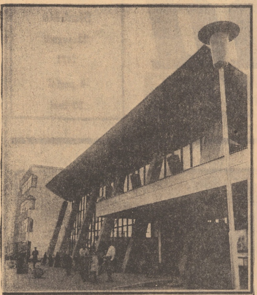
Impunătoarea construcție a gării din municipiul Medias, o mîndrie a orașului de pe Tîrnave
