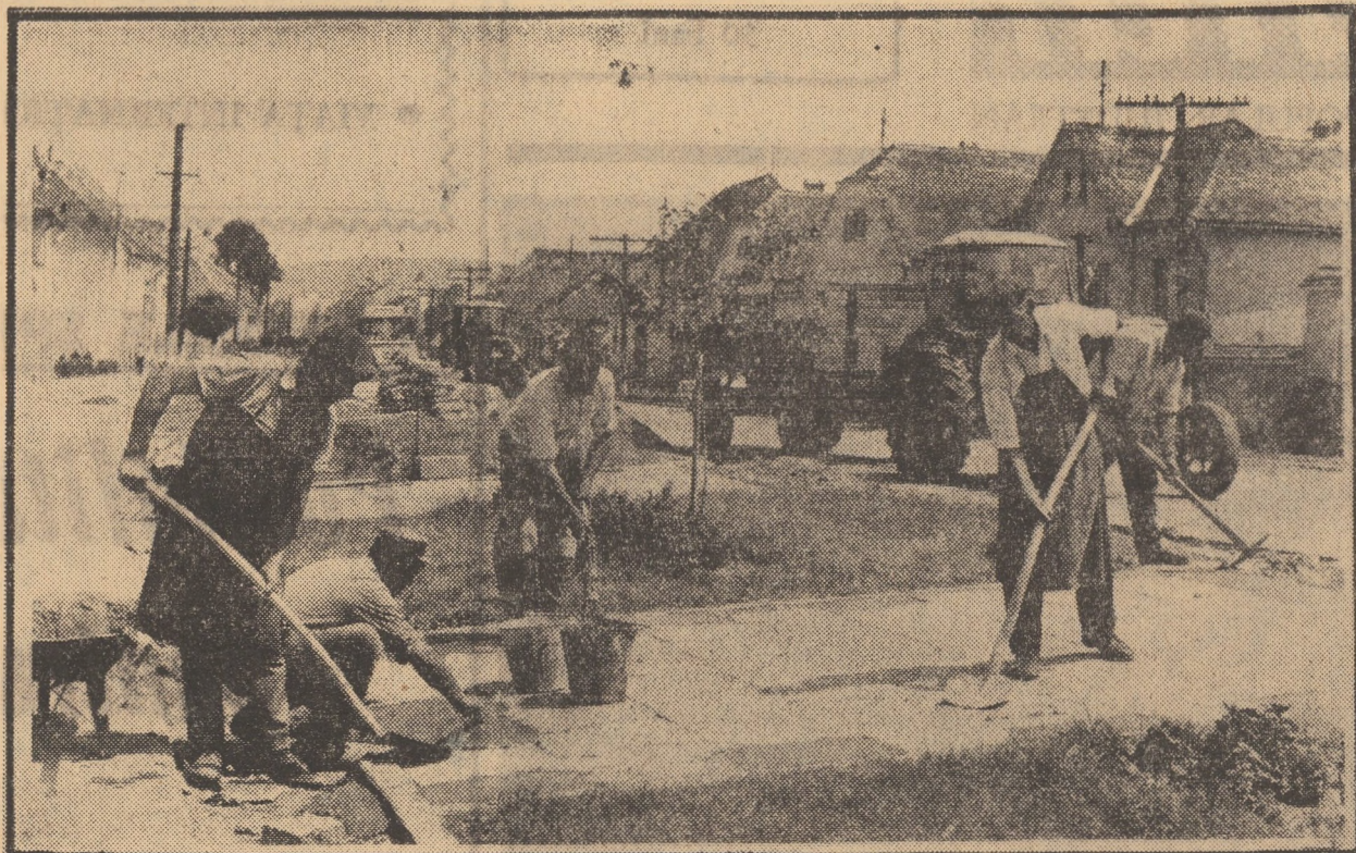
Ediții orașului Agnita la lucru: se pun borduri mozaicate și dale din beton la intrările în curți, se lărgeste partea carosabilă pe str. M. Viteazul.
