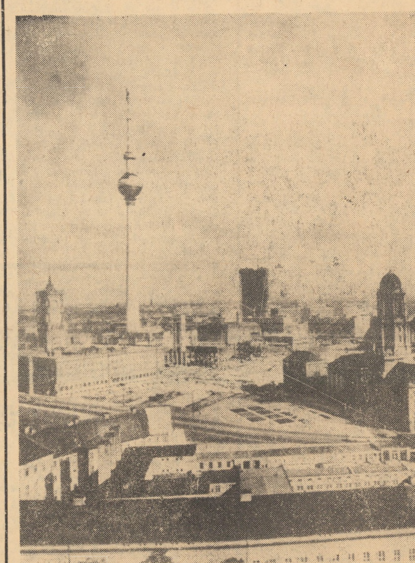
R.D. GERMANIA. Șantierul noilor construcții din centrul capitalei — Berlin — unde vechile clădiri ale Primăriei și Consiliului de Miniștri vor fi flancate de îndrăznețe construcții moderne
