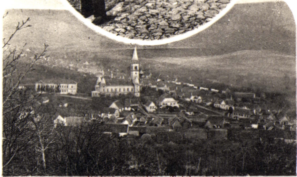
Vedere generala — Totalansicht
